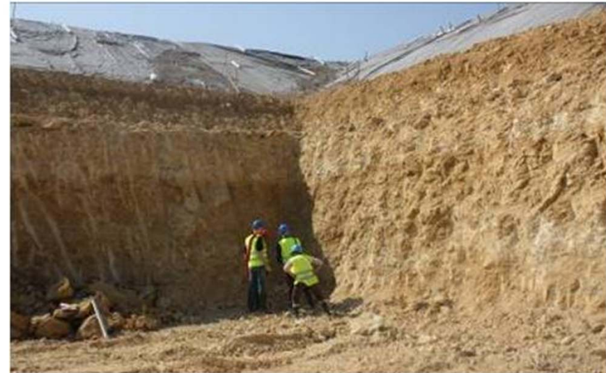
Chantier SPIRAL2 au 22 avril 2011
