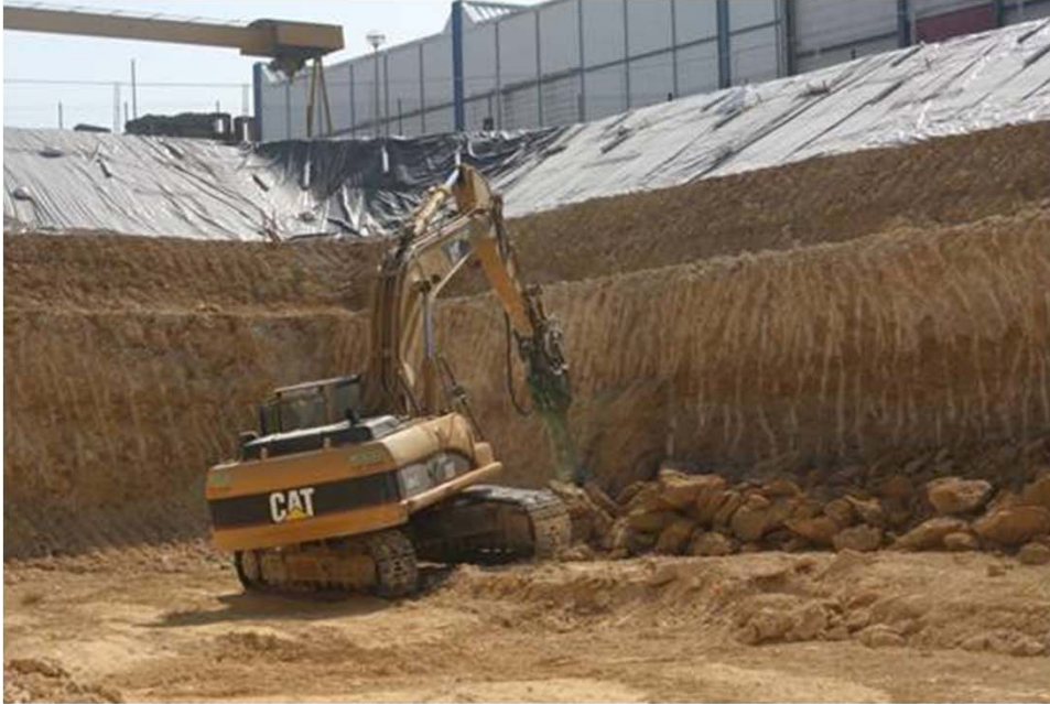
Equarrissage des talus
